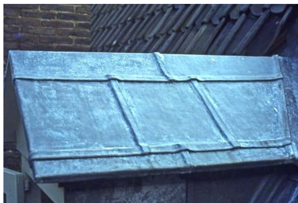
Dakkapel afgedekt met verschervend aangebrachte loodplaten.
