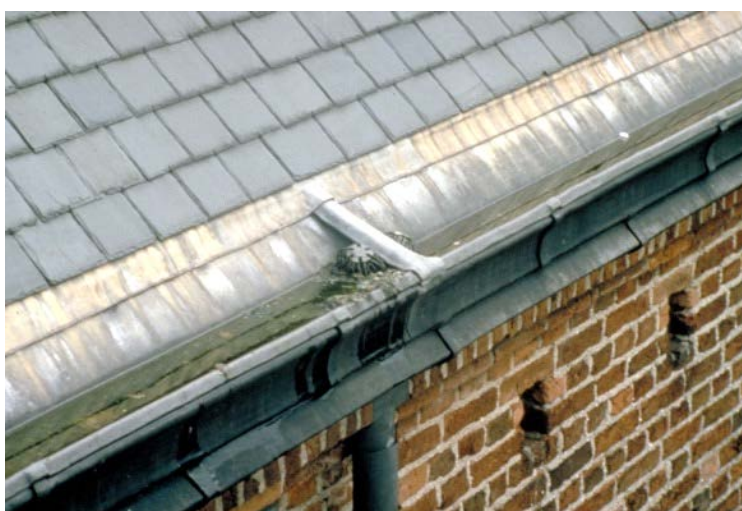
Met lood beklede schampgoot aan de dakvoet van een kerk.
