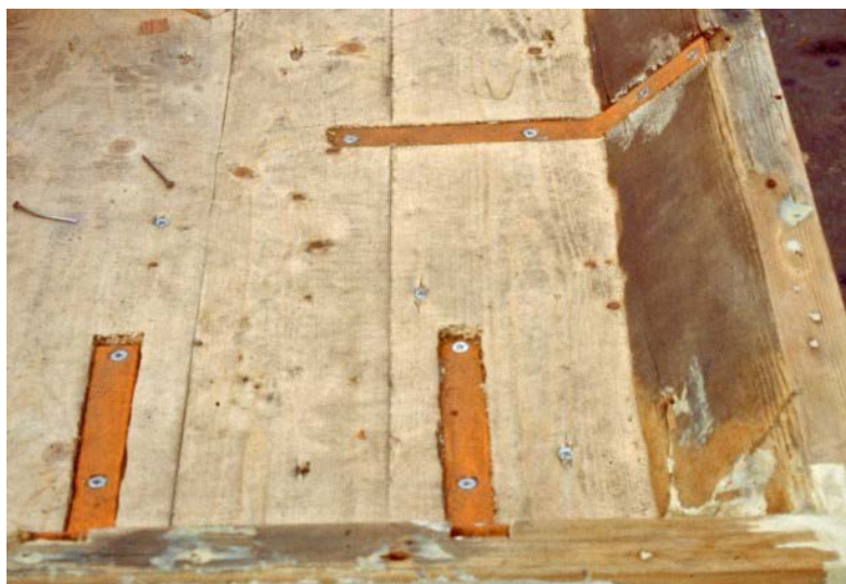
Figuur 2: Neusijzers verdiept aangebracht en vastgezet op de gootbodem, voordat deze afgedekt worden met een strookje DPC
